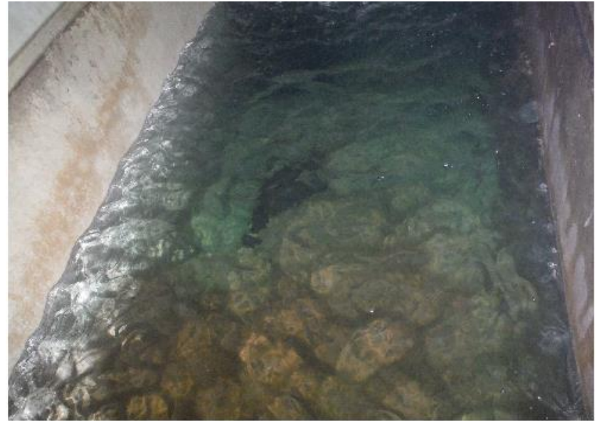
第三階段實驗：七天後水池內部狀況
