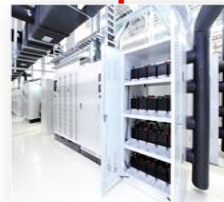
UPS電池箱安裝 風管
