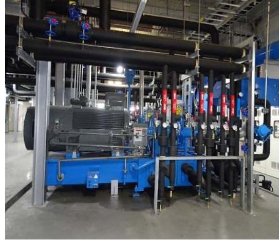
空壓機第一段與第二段壓縮空氣使用溫水冷卻 第三段使用冰水冷卻
