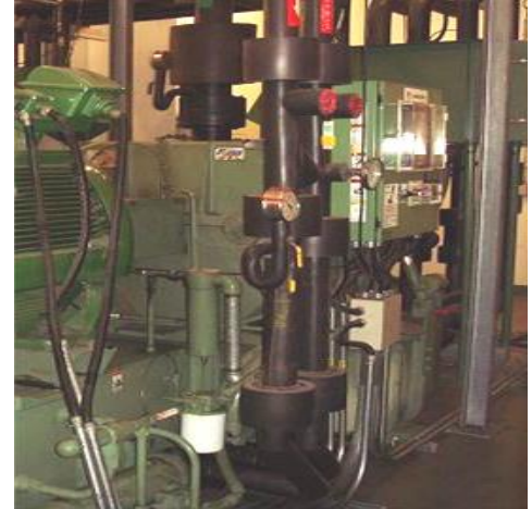
空壓機第一段與第二段壓縮空氣使用溫水冷卻 第三段使用冰水冷卻
