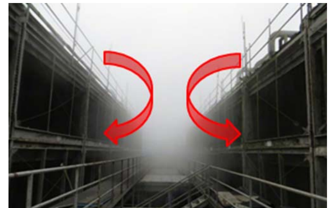
圖9 水塔中間區域短循環
