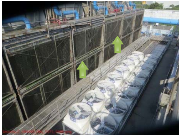
圖12 軸流風扇安裝圖
