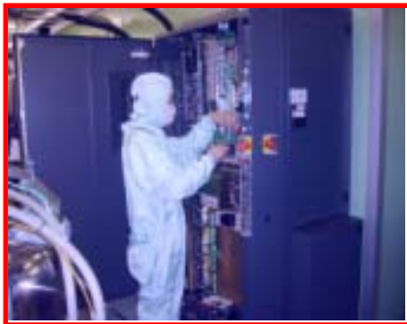
控制盤內線路修改過程修改
