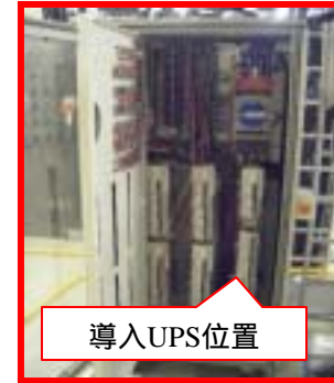
Lam AC Box UPS 導入接線位置
