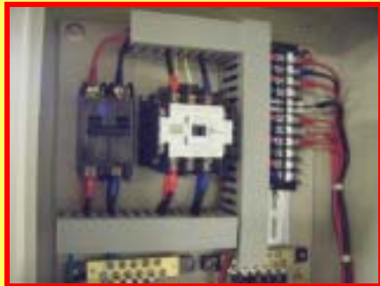
UPS 控制電源箱內部配置
