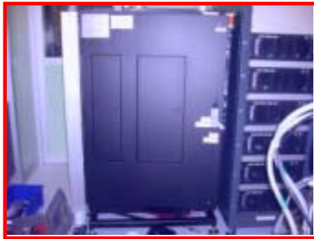
修改線路主電源盤外觀
