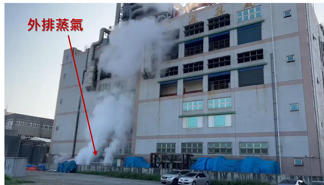
圖3. 未設置ORC前多餘蒸汽外排情形
