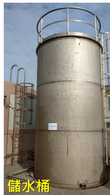
圖6. 本廠變電站及廢熱鍋爐儲水桶
