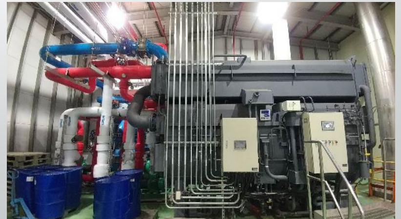
熱水型 220RT 吸收式冰水主機
