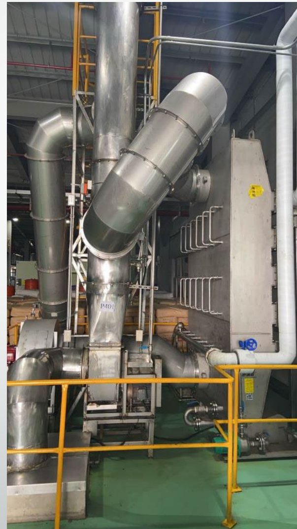
排熱回收板式熱交換器
