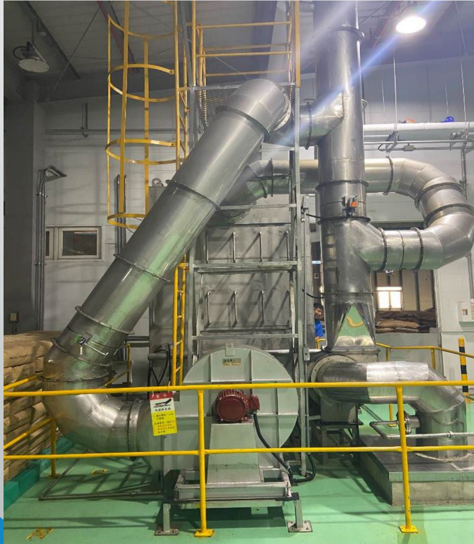
排熱回收板式熱交換器
