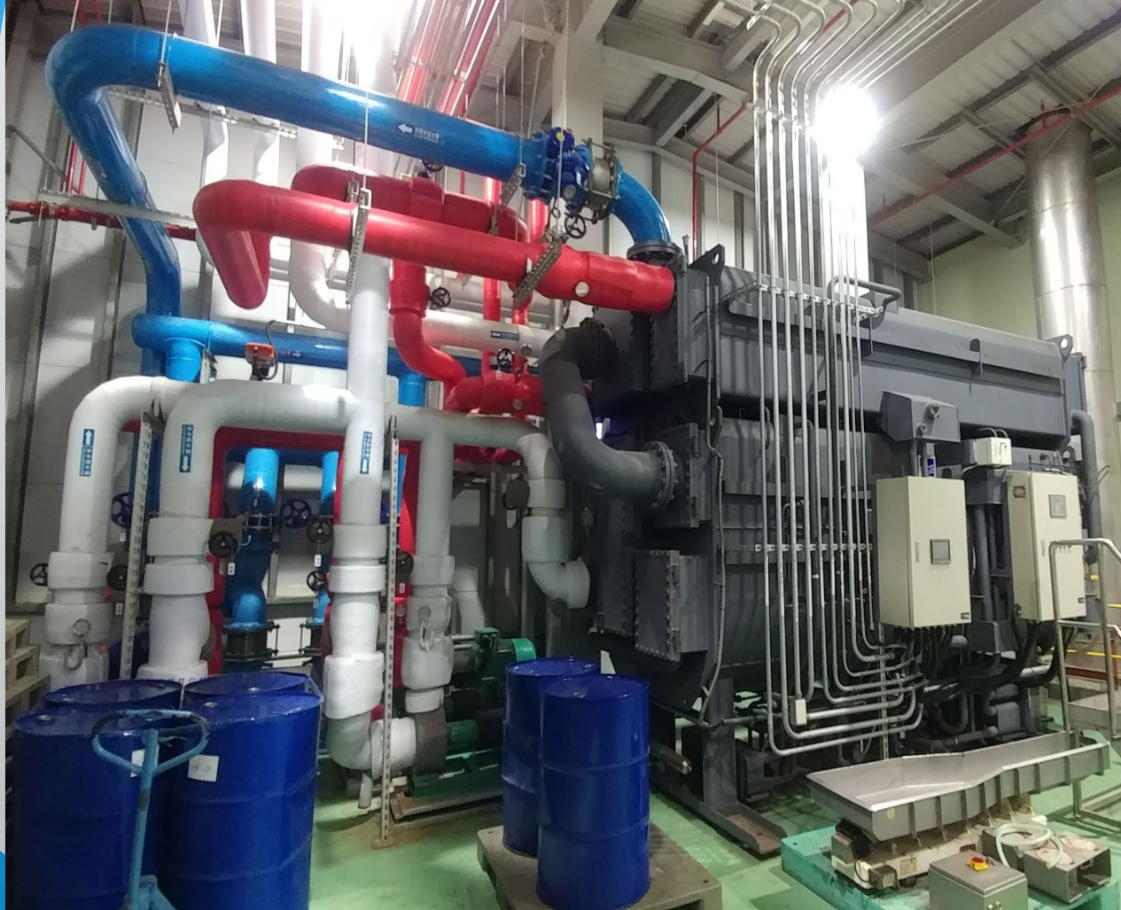
熱水型 220RT 吸收式冰水主機
