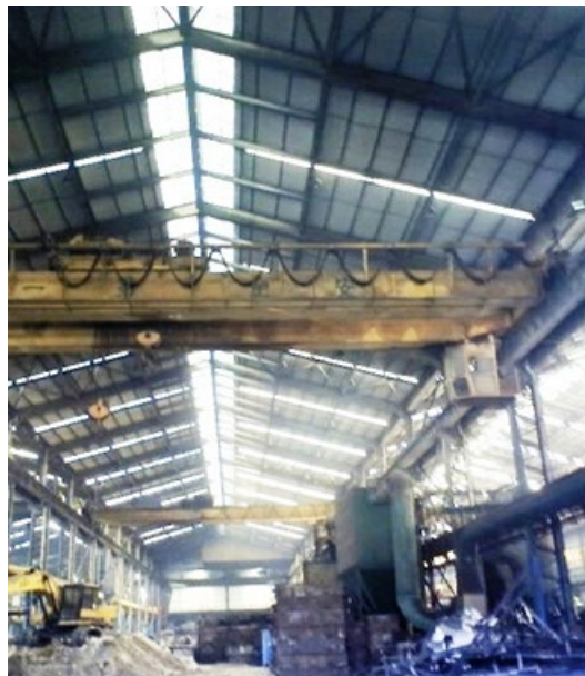
圖 54. 中鋼機械 C 廠中間氣樓亦增加採光照片
