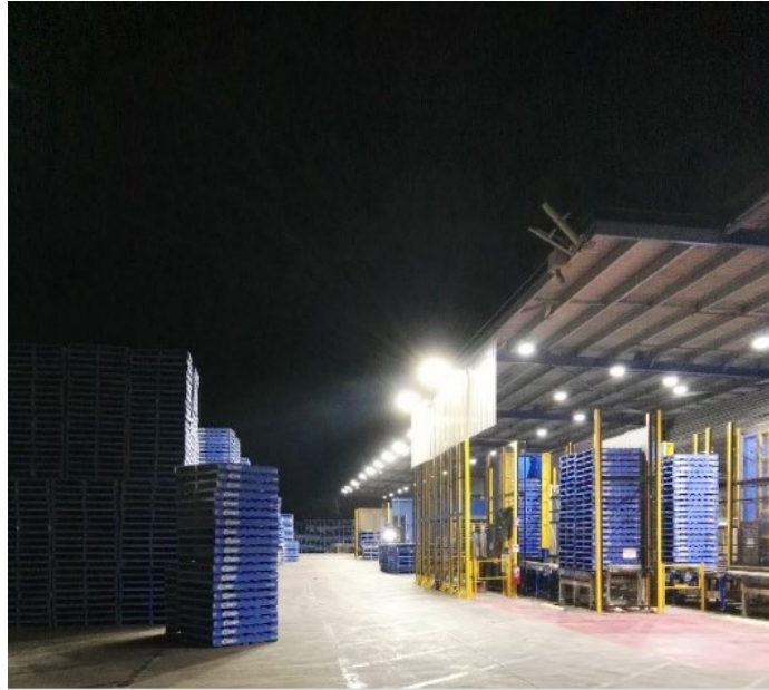
圖 51. Chep 大型倉庫改善高架燈後照片 2
