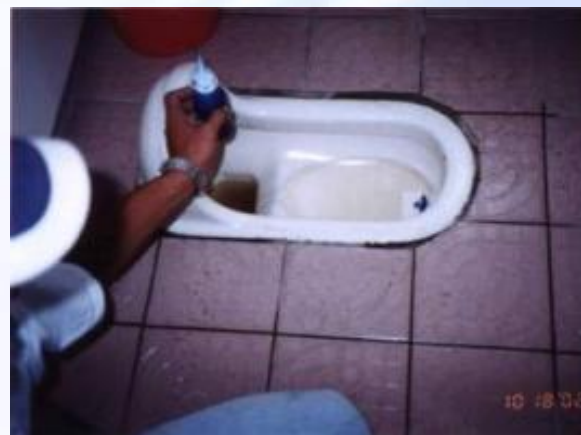
蹲式馬桶測漏—未漏
