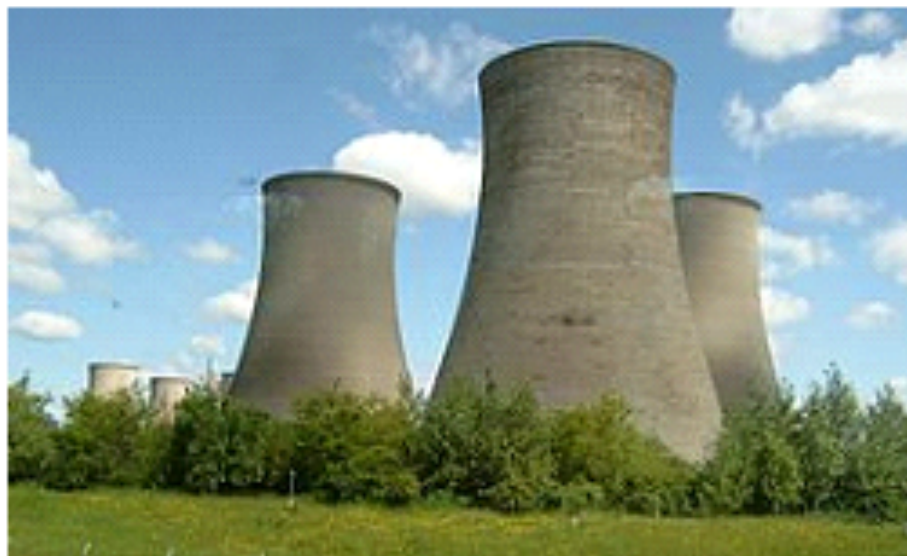
火電廠冷卻塔，使用數量 1~4，直徑 110m
