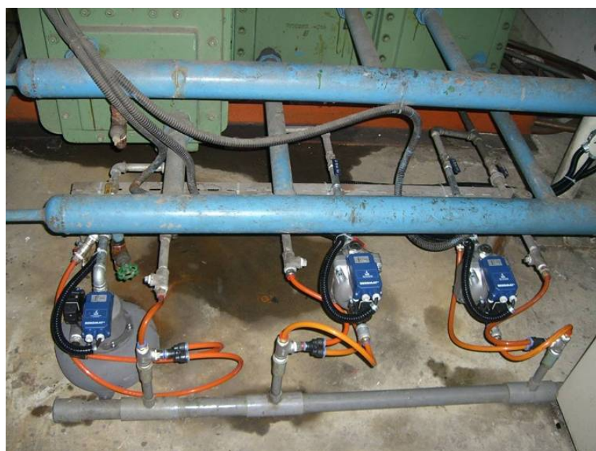
圖19 排水器安裝後
