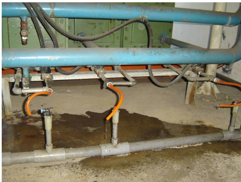
圖18 排水器安裝前
