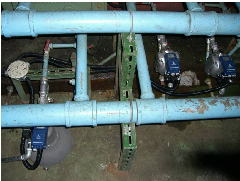
圖15 排水器安裝後
