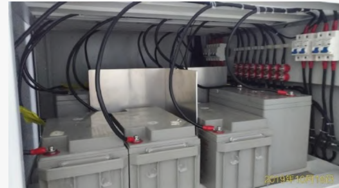
汰役電池儲能系統機櫃 內部電池配置圖
