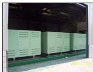
精密螺絲製造業廢水脫鹽回收 (350 m 3 /d)
