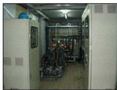
虎生電子冷卻水回收(550 m 3 /d)
