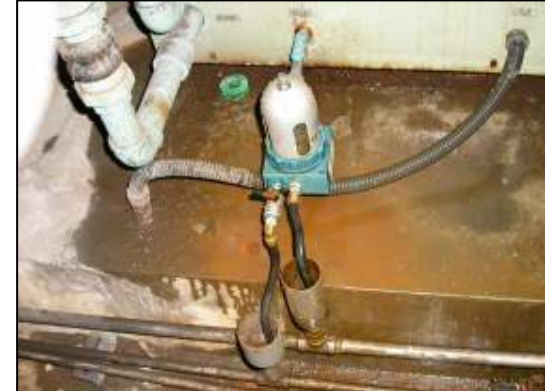
浮球式卻水器排水洩漏
