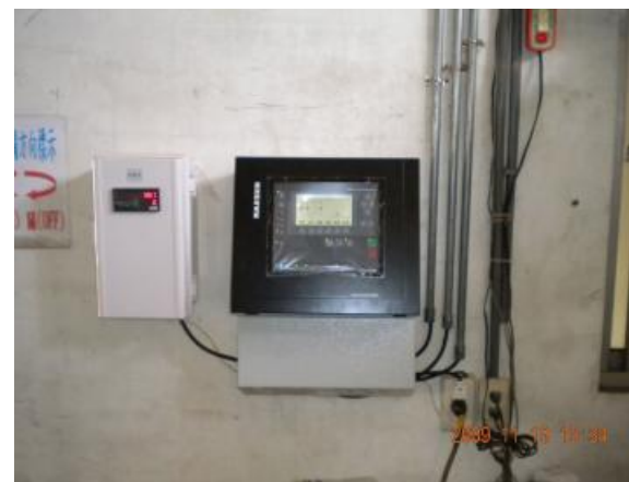
圖六、SAM中央監控控制器(中) 與流量顯示器(左)
