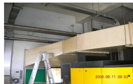
圖十五、流量計安裝位置
