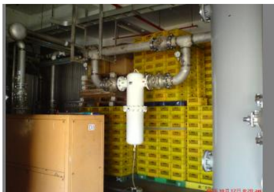
圖八、新裝前置空氣精密過濾器
