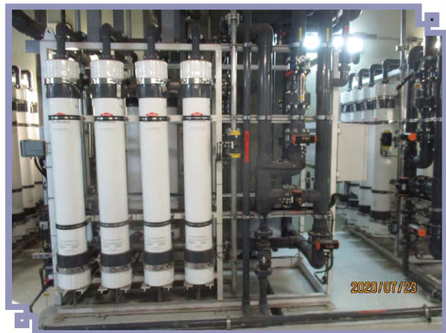
▲切割廢水回收系統 UF 超濾膜
