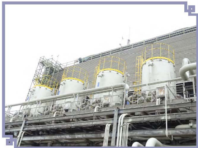
▲ 冷卻水塔旁流過濾設備
