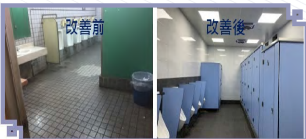
▲廁所更新安裝省水器材
