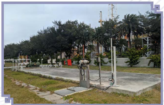
▲儲槽區雨水回收槽
