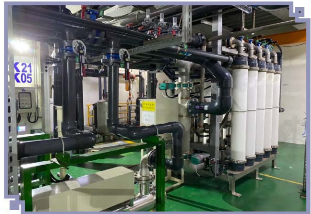
▲無藥 DS 切割研磨廢水 UF 回收系統
