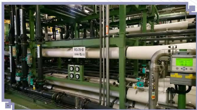
▲低濃度有機廢水回收至 AWR 系統
