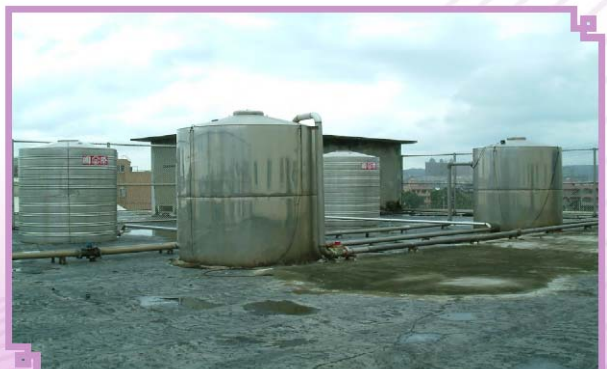
▲ 自行節水措施—冷卻水回收桶
