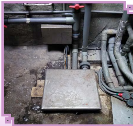
▲ 建置筏基坑回收水設備提高雜排廢水回收再利用量
