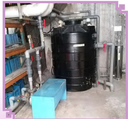
▲ 建置筏基坑回收水設備提高雜排廢水回收再利用量
