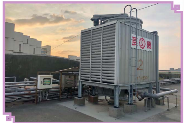
▲新增冷卻水塔
