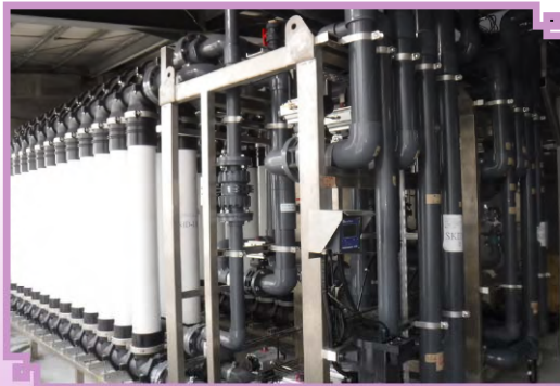
▲ 落實節水建議措施 - 中水回收系統 (左)UF 模組 (右) RO 模組
