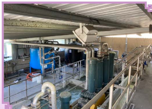
▲ 增建回收系統與水槽提高製程廢水回收再利用量 (左) 回收水槽 (右) 回收系統
