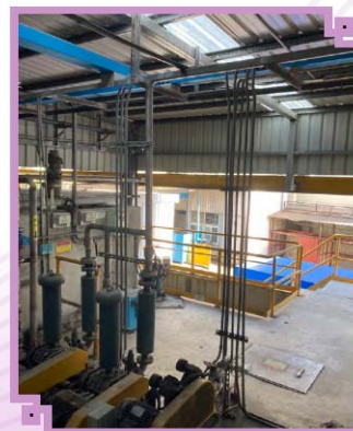
▲ 空污防制灑水系統：(左) 灑水回收系統 (右) 前處理逆洗水回收設備
