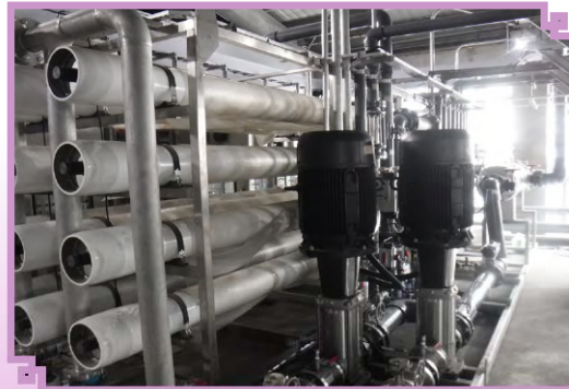
▲ 落實節水建議措施 - 中水回收系統 (左)UF 模組 (右) RO 模組
