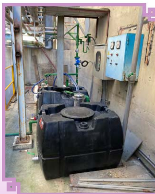
▲ 空污防制灑水系統：(左) 灑水回收系統 (右) 前處理逆洗水回收設備
