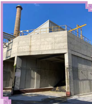
▲ 增建回收系統與水槽提高製程廢水回收再利用量 (左) 回收水槽 (右) 回收系統
