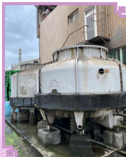
▲ 冷卻水塔改善
