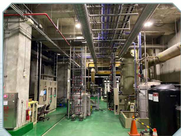
▲既有挑高樓層活用增設水處理設備
