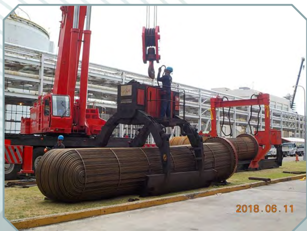
▲ E-477 更換管束以降低 E-027 蒸汽耗用量
