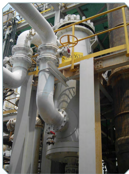
▲ 廢氣、液燃燒爐增設冷卻器
