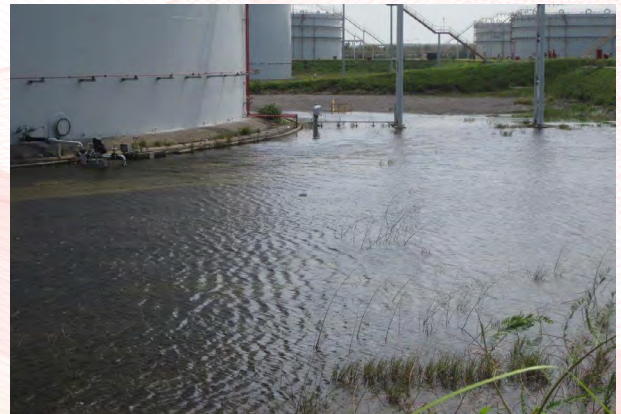
▲煉油廠各製程區及槽區雨水收集貯留
