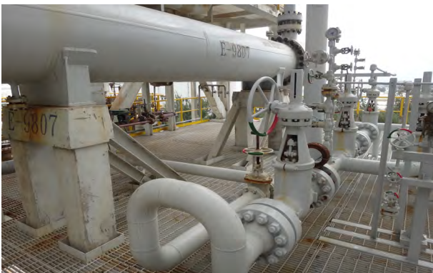
▲ 異構脫臘單元水冷式換熱器 (E-9807) 之冷卻水端旁流節水
