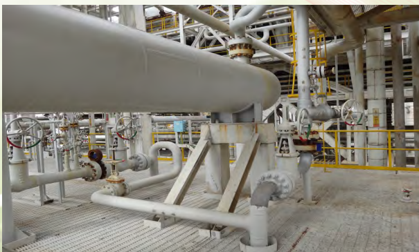
▲異構脫臘單元水冷式換熱器 (E-9807) 之冷卻水端旁流節水
