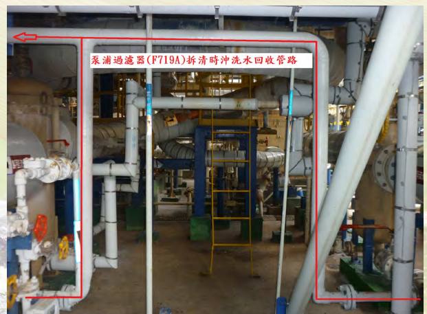
▲ 泵浦過濾器 (F719A) 拆清時沖洗水回收
