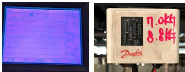
圖5-3 空壓機電壓量測及空氣壓力設定
