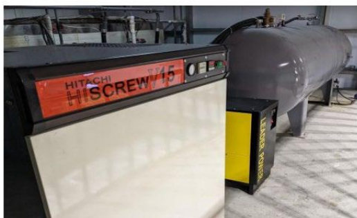
圖5-1 空壓機系統
