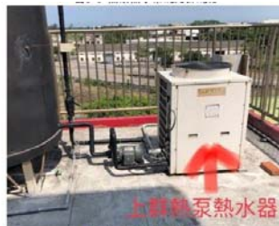
圖1-2 熱泵熱水器系統現況
