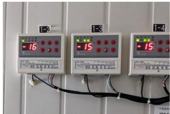
圖3-4 冷凍冷藏庫溫度設定
