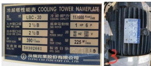
圖3-2 冷卻水塔其冷卻水循環泵規格
