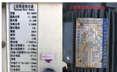
圖1-1 熱泵熱水器系統規格表
