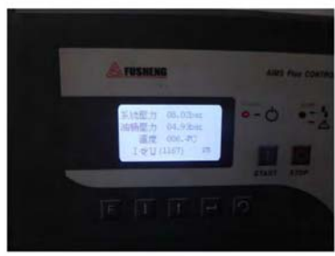
廠用空壓機系統壓力 由9bar調降到8bar
