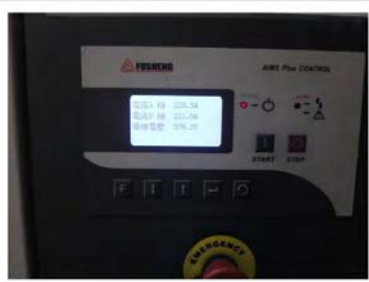
廠用空壓機平均運轉電流 由240A降為220A
