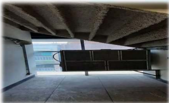
原玻璃帷幕外牆內側(施作前)
