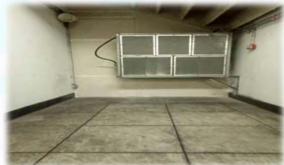
增設遮光隔熱設施(施作後)
