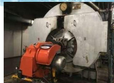
鍋爐燃燒機汰換(改用潔淨能源) 減碳1,224噸/年
