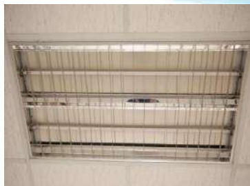
節能燈具汰換 節電172,645kwh/年 減碳95.6噸/年
