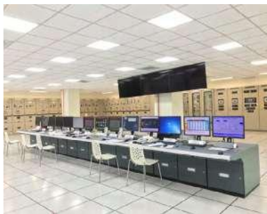
設置中央監控系統
