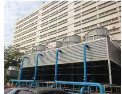
#3.4.6.7冷卻水塔汰換
