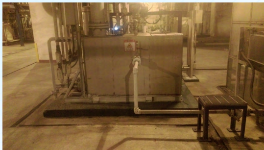
▲ 押出機循環水槽增設連通管平衡液位
