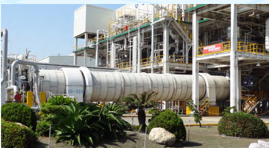
▲ 乾燥機低壓蒸汽回收
