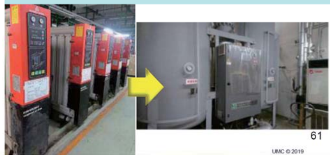
無熱式乾燥機修改為外熱式乾燥機
