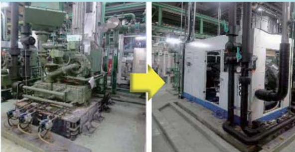
離心式空壓機改為螺旋式變頻空壓機
