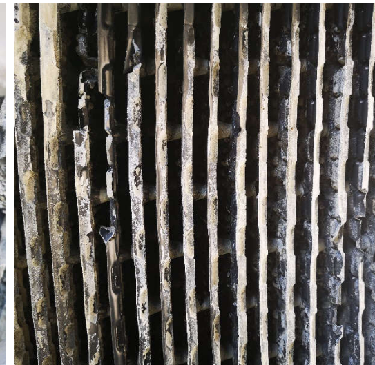
散熱材破損，系統管路堵塞及設備損壞疑慮，影響冰機效率
