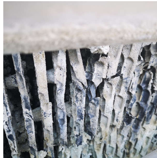
散熱材破損，系統管路堵塞及設備損壞疑慮，影響冰機效率
