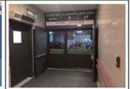
增設自動門+空氣簾減少 空調損失
