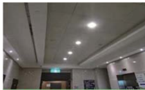
電梯梯廳及樓梯照明改善
