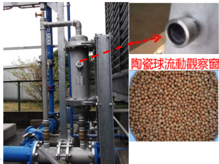
圖 16 陶瓷球處理系統理論
