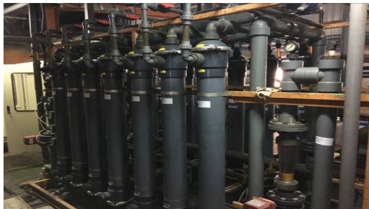
■ 圖 23 微過濾處理系統設備圖
