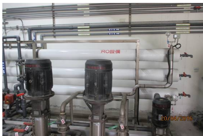
■ 圖 25 奈米過濾處理系統設備圖
