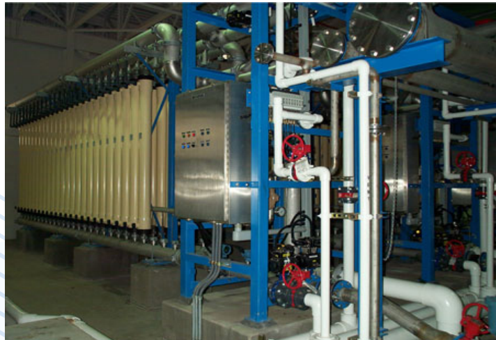
■ 圖 9 微過濾系統設備圖
