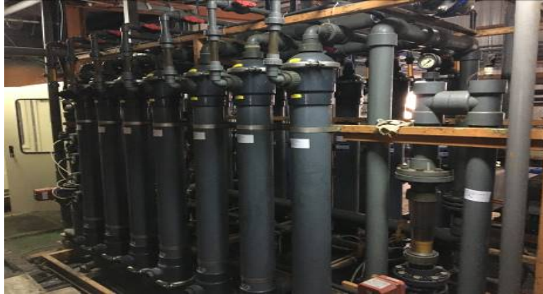
■ 圖 10 超過濾系統設備圖
