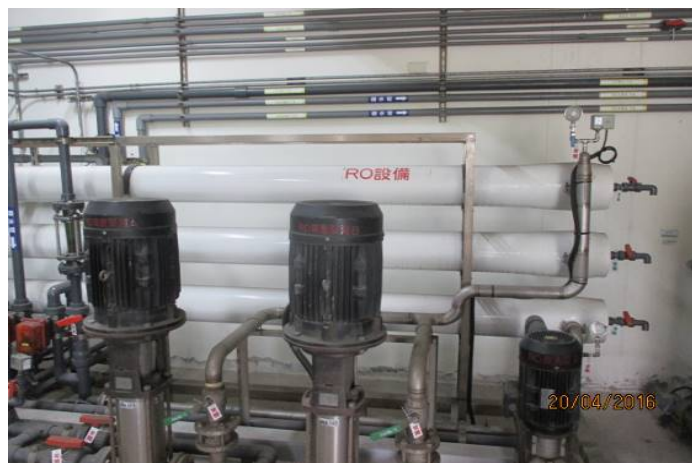
■ 圖 11 奈米過濾系統設備圖
