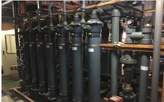
■ 圖 31 超過濾系統設備圖
