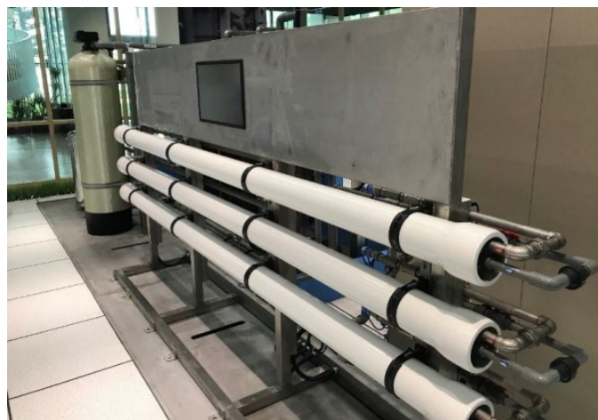
■ 圖 31 超過濾系統設備圖
