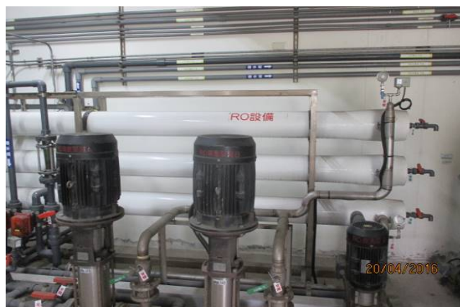
■ 圖 32 奈米過濾系統設備圖
