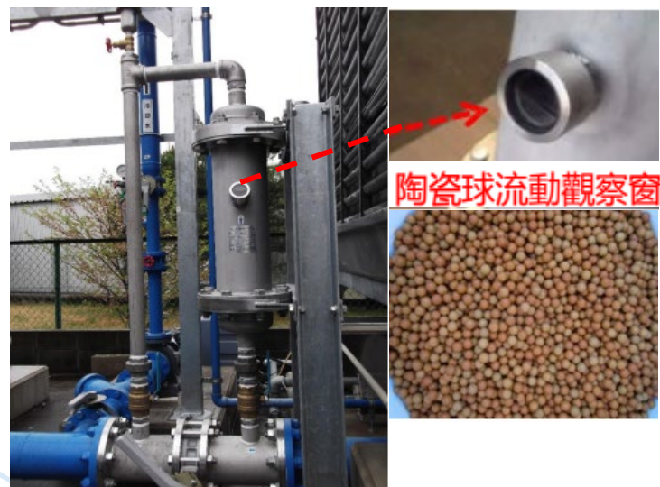
圖 21 陶瓷球水處理系統理論圖
