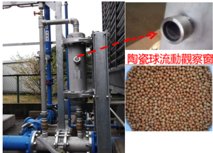
圖 22 陶瓷球處理系統理論圖
