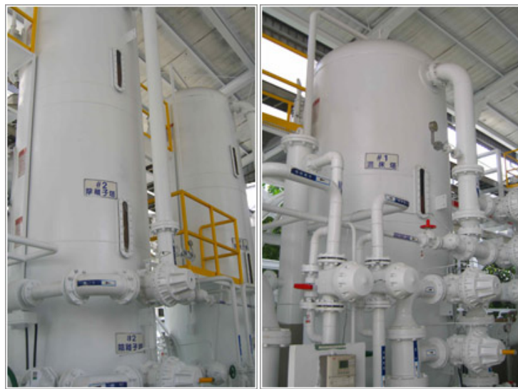
■ 圖 32 離子交換樹脂設備
