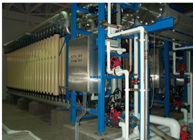
■ 圖 10 微過濾薄膜設備圖
