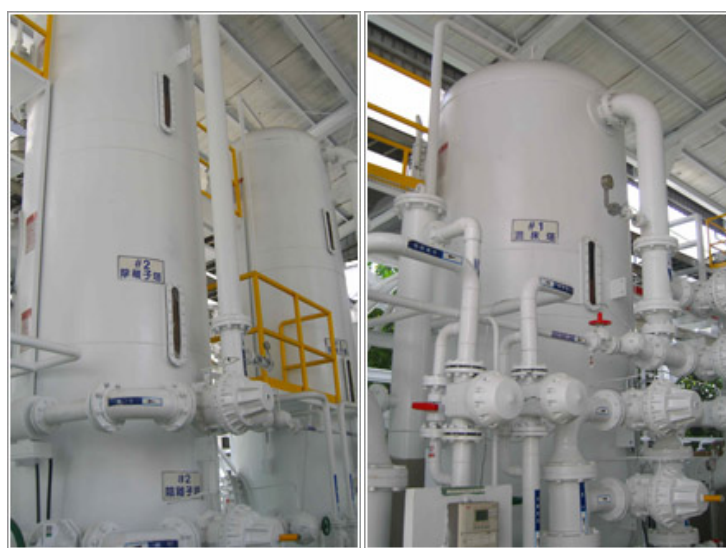
■ 圖 32 離子交換系統設備圖
