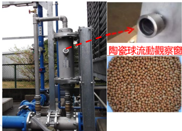
圖 23 陶瓷球處理系統設備圖
