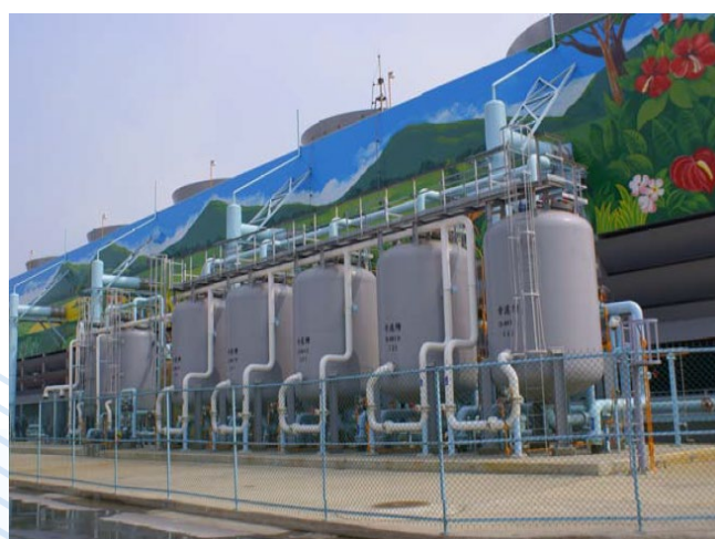
圖 16 旁流過濾處理示意圖
