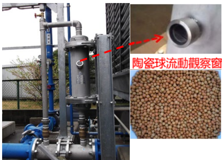
圖 26 陶瓷球水處理系統設備圖
