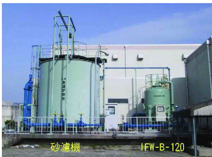
■ 圖 9 傳統砂濾機與高速纖維過濾器實體比較圖
