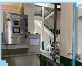
▲ 增設回收水配管至污泥泡藥系統
