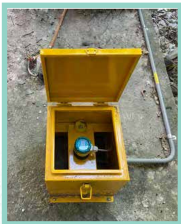
▲水位計：用來偵測水撲滿液位，偵測之數據可於遠端電腦查看。
