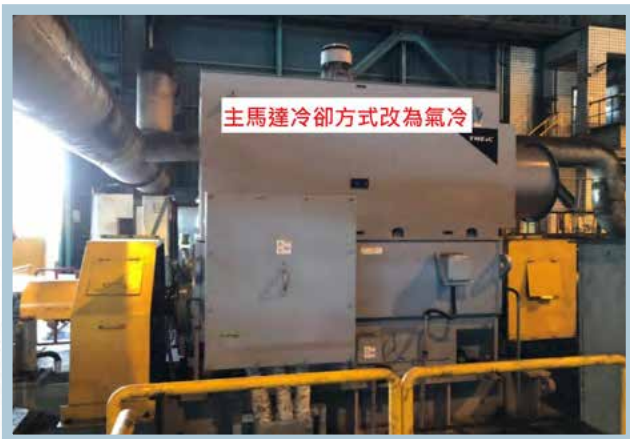
▲ #3TNRL 主馬達冷卻方式改為氣冷
