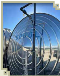
▲ 回收至自來水槽供冷卻水使用
