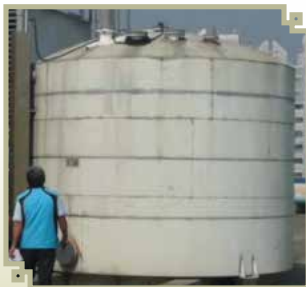
▲ UF 回收貯槽及輸送設備
