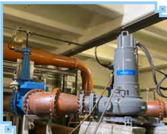
▲ 增設回收水配管進行泵浦冷卻
