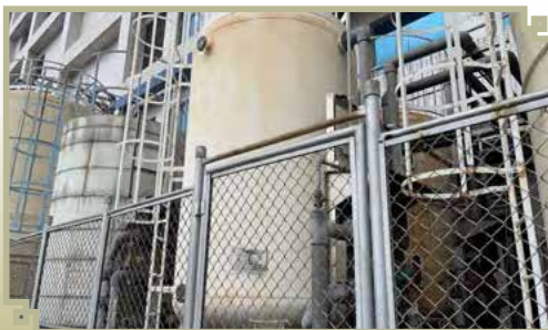
▲ 中水回收系統 (左)UF 模組 (右) RO 模組
