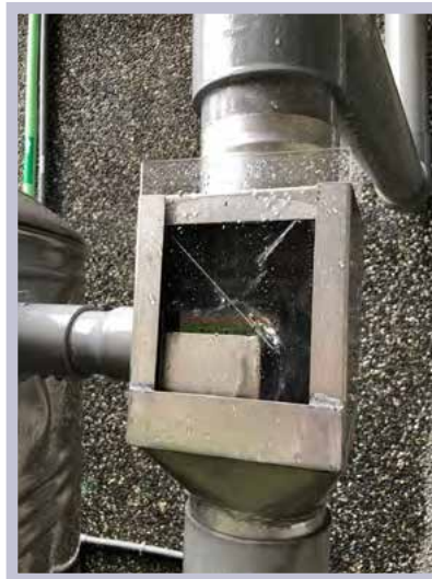
▲自製雨水過濾器，透明隔板以利教學
