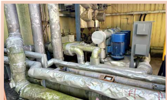
▲祛水器、手閥開關、馬達軸封、漏水管線等老舊設備更換
