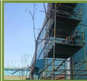
Cable Tray 搭架施工
