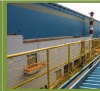
欄杆增設防墜網
