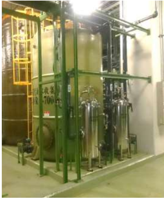
新設桶槽及過濾器
