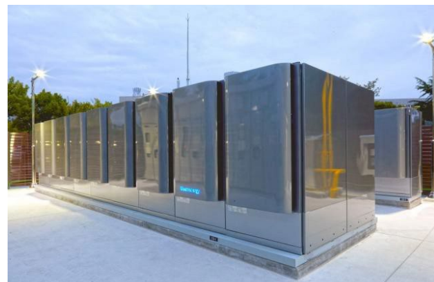
燃料電池 ，使用固體氧化物燃料電池技術，將天然氣、生質能或氫氣高效轉化為電能，無需燃燒。
