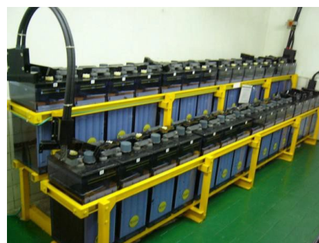
鉛酸電池 ，電極主要由鉛製成，電解液是硫酸溶液的一種蓄電池。
