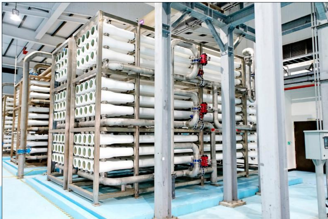
永康再生水廠第二階段擴廠，加設RO模組。(南市水利局網站)
