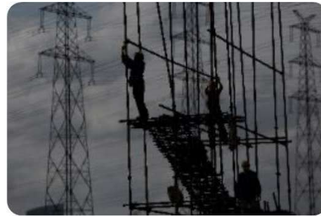
集中式電網老化 電網老化、脆弱度問題造成發電成本上升
