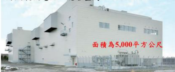
2015年於北海道安平町/南早來變電站，運用鈳液流電池，總容量為15MW/60MWh
